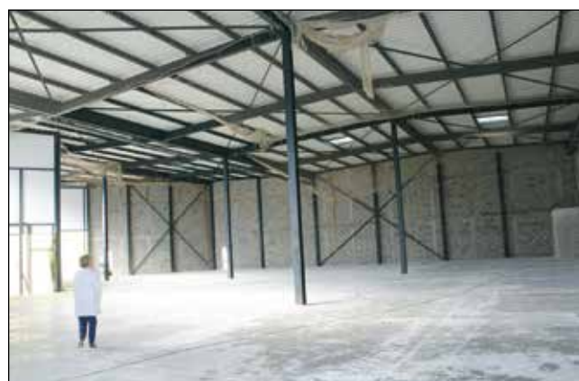
Le management est extrêmement participatif, ainsi pendant les phases de travaux, les collaborateurs ont été aussi consultés pour l'aménagement de la future extension.
